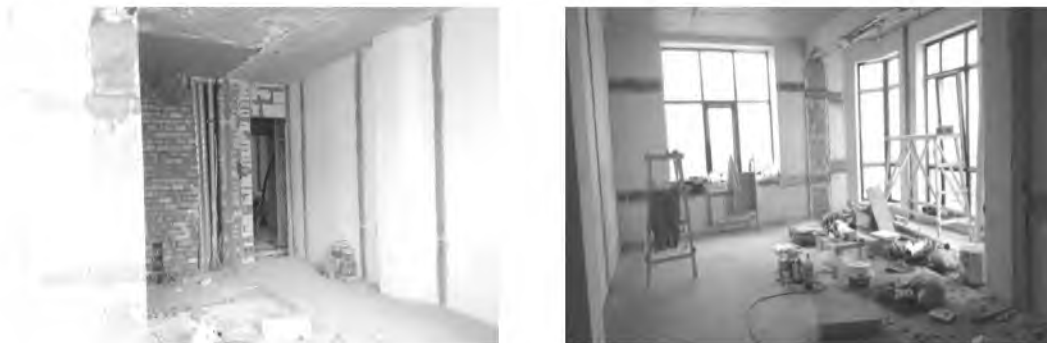
Рисунок 2. Подготовительные работы (снятие перегородок)
